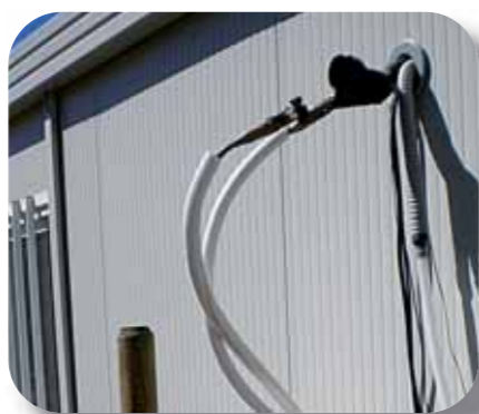
Raccordement au réseau électrique de la fromagerie modulaire
